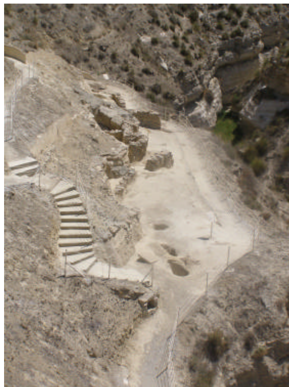
Cortado de la terraza intermedia con la protección conservada y recrecida y la nueva que se prolonga en sus laterales
