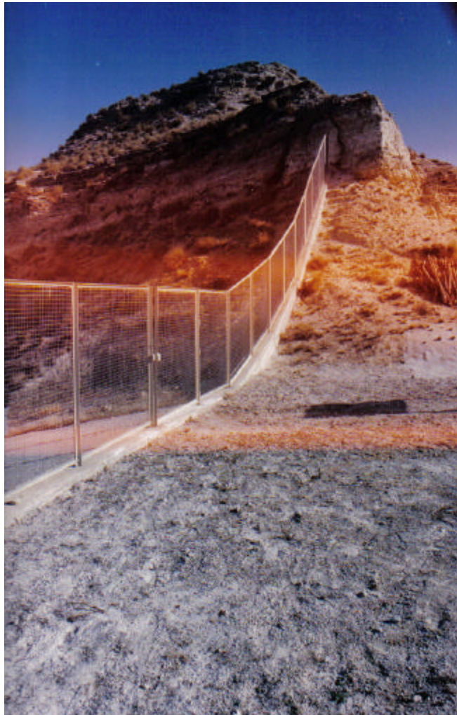
Vista del cerramiento del yacimiento, realizado siguiendo la máxima pendiente del terreno y paralelamente a la muralla de la acrópolis
