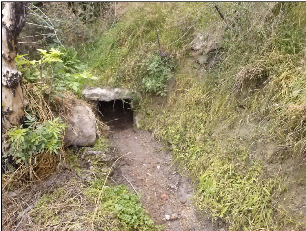
Zona en galería cercana al punto de medición.
