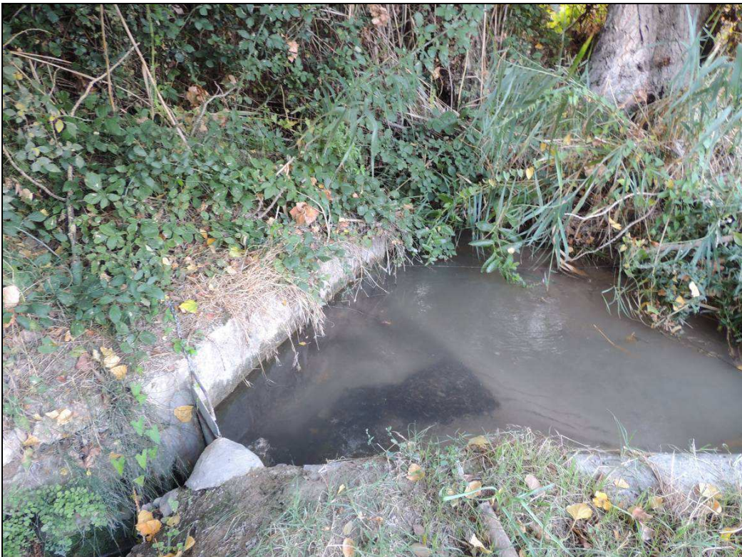
Acequia principal 2. Pk 0+000.
