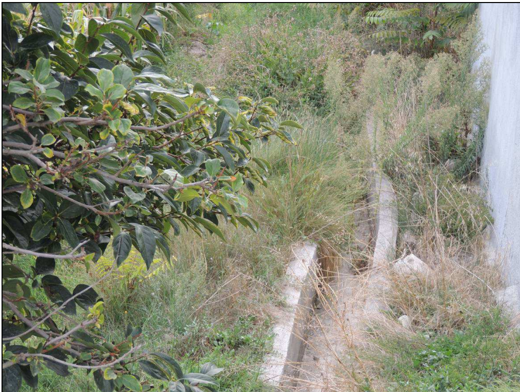
Acequia del Pago del Nacimiento, hormigonada en su comienzo tras la zona empantanada, sin presencia de agua.
