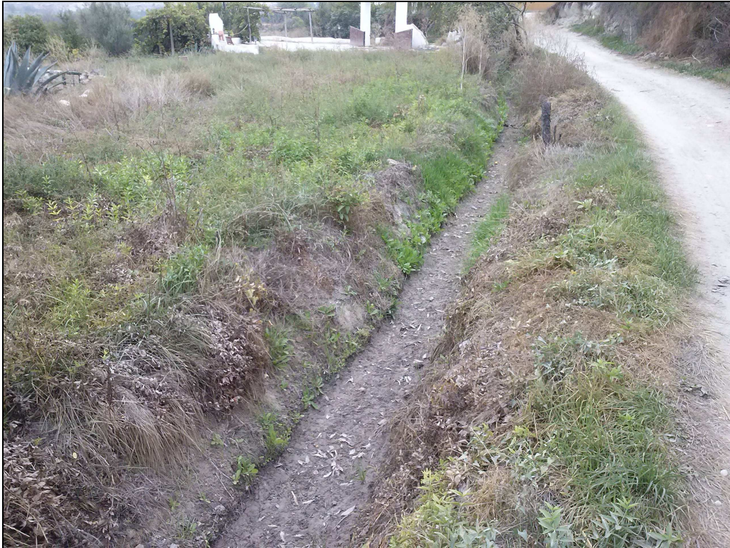
Imagen de la zona donde se tomó la medición, esta vez sin agua, donde pueden apreciarse las labores de limpieza llevadas a cabo.
